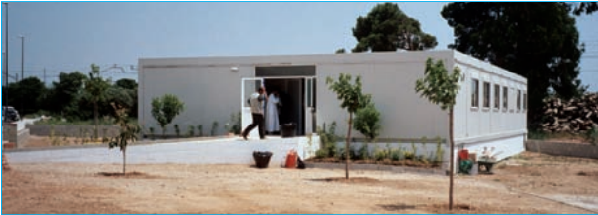
FOTOS 8, 9 i 10. Oratoris emplaçats en mòduls prefabricats (Reus, Santa Coloma de Gramenet i L'Hospitalet de Llobregat)
