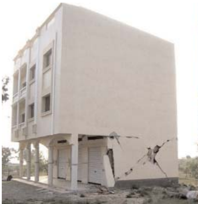
Figure 4. Construction à Ajdir, réparée avec de nouveaux piliers plus épais. / PATRICK MURPHY
